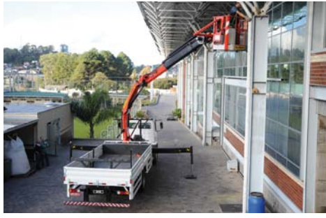
ARBEITSKÖRBE SICHERES ARBEITEN
