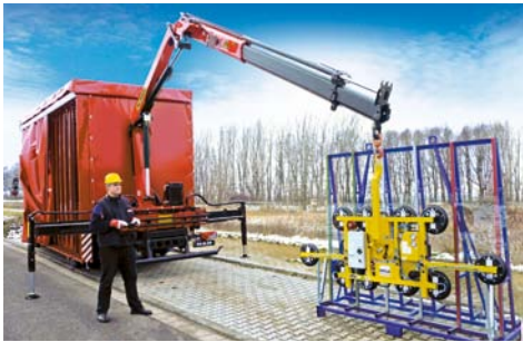
GLASSAUGHEBER SICHERES ARBEITEN
