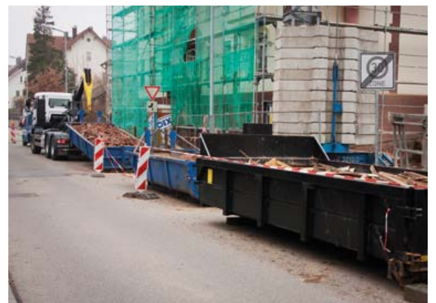
Containerwechsel auf der Baustelle
